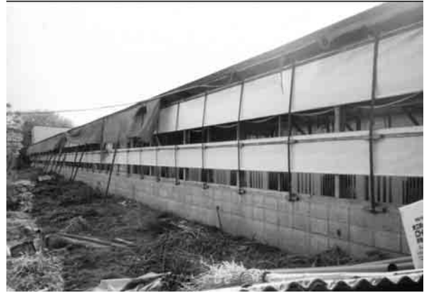
写真2 肉豚舎のカーテンが巻き上げ式のため、換気時に外気温の影響を受け易い。
