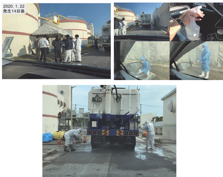
図9 消毒ポイント⑤-名護市下水処理場 適正な消毒方法へ改善するよう要請した翌日の状況
