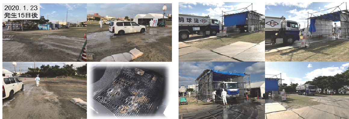
図8 消毒ポイント④-沖縄市農民研修センター（消毒路面の悪化と改善後の状況）
